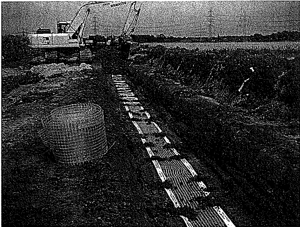
Bild 1: Rohrgraben mit Geo-Grid-Matte und Trassenwarnbändern
