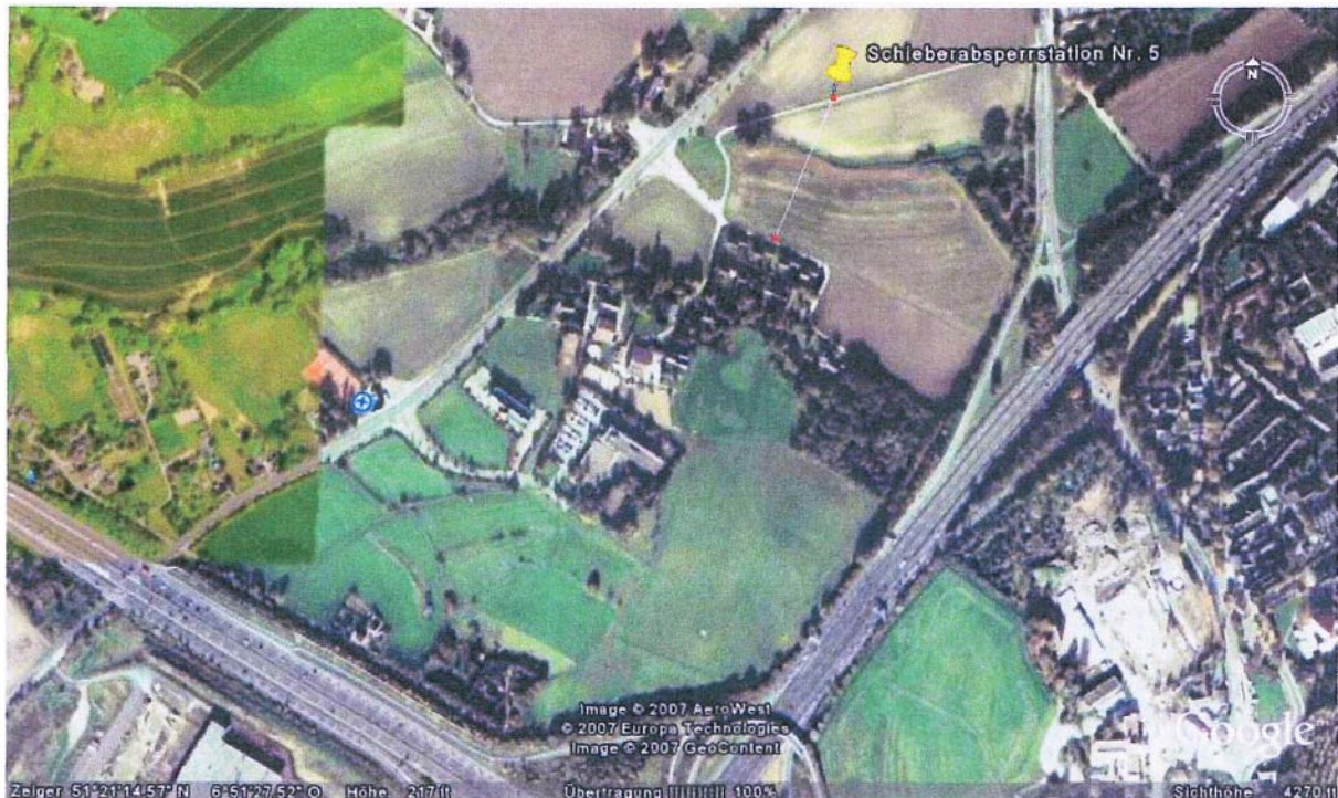
Abb.3: Schieberstation 5 in Breitscheid ( Ratingen) in unmittelbarer Nähe des Autobahnkreuzes Breitscheid mit einem Abstand von 150 m zur nächsten Bebauung
