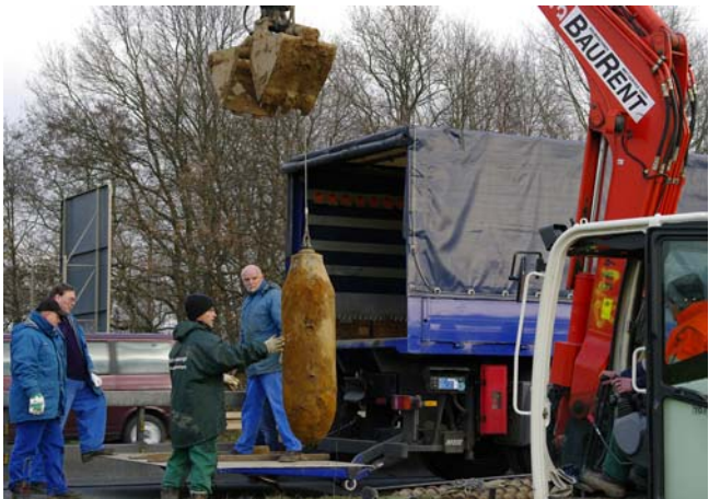
Foto: Ralf Hohl Abtransport Kampfmittelfund nahe der CO-Pipeline
