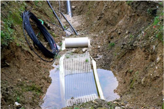
Rohrgraben mit GeoGrid und Trassenwarnband
