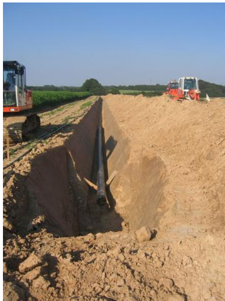
Die CO-Pipeline bei Düsseldorf-Hubbelrath während des Baus im Jahr 2007. [Foto: wikicommons/Gaßner]
