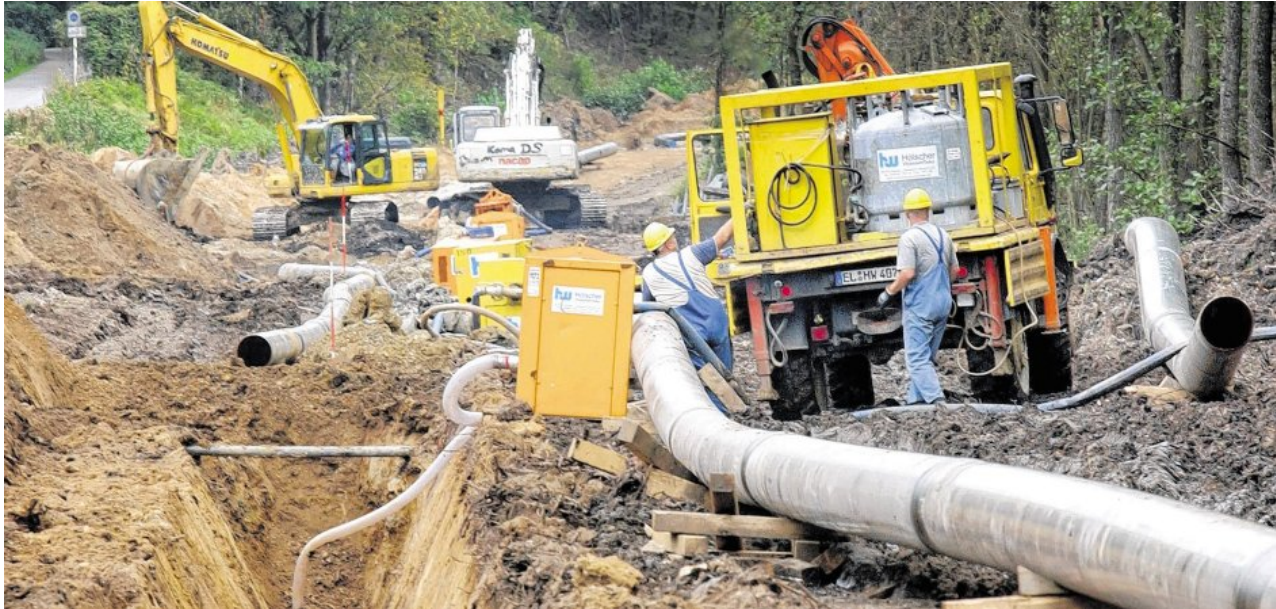
Foto: Horst Ossinger/dpa/Archiv So sah die CO-Pipeline im Jahr 2007 aus, als sie in Duisburg gebaut wurde.
