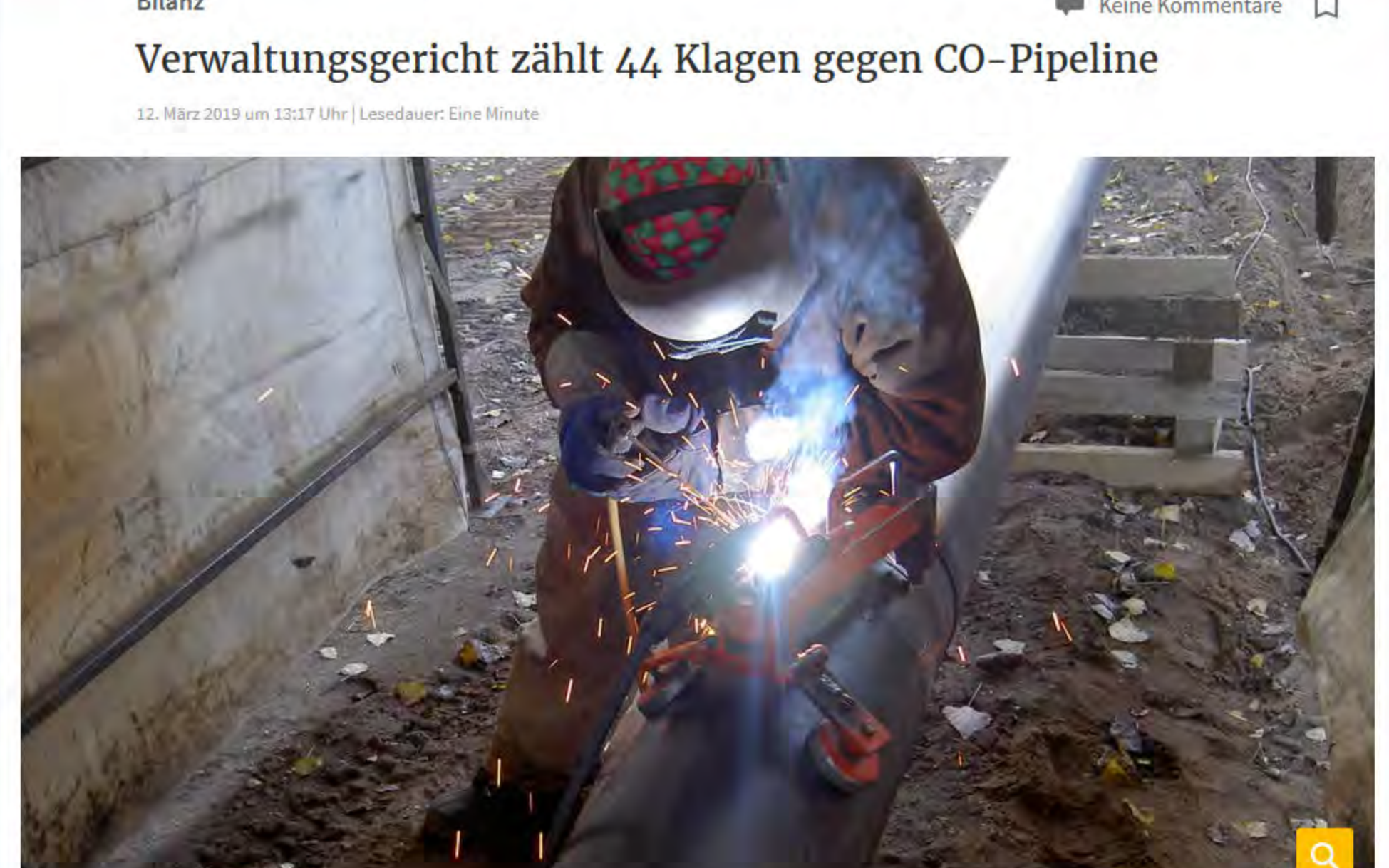
Schweißarbeiten an der umstrittenen Kohlenmonoxid-Leitung. Foto: Erwin Schumacher
