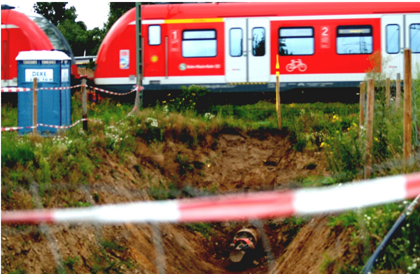
Oben die S-Bahn in voller Fahrt und unten klopft und presst Bayer im nächsten Versuch, die Giftgas-Leitung zu reparieren
