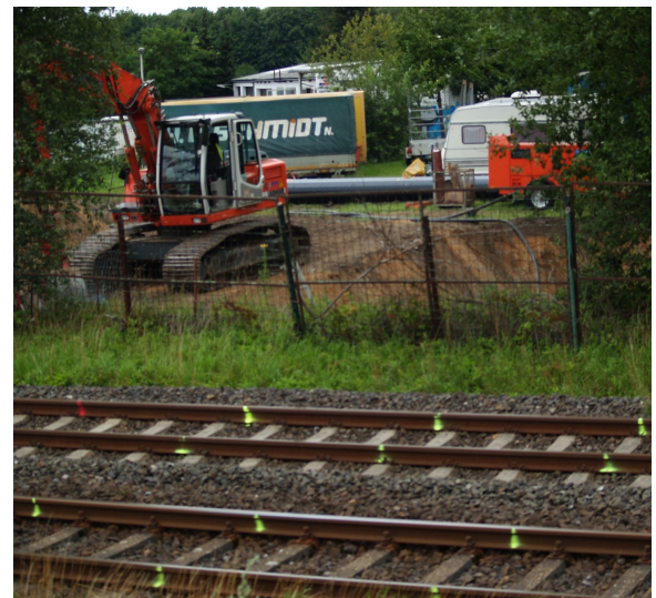
Pressgrube und Ersatz-Mantelrohre im Hintergrund; vorne Markierung auf den S-Bahn-Gleisen
